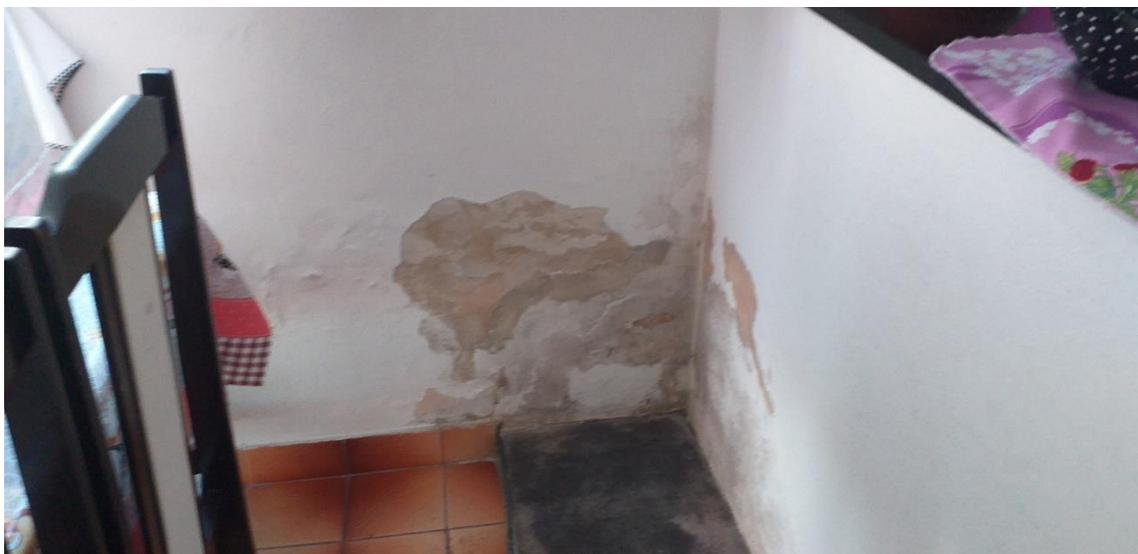
Nas fotos acima da cozinha, pode se confirmar diversos pontos de umidade nas paredes.
