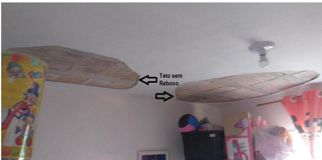
Nas fotos acima se observa a falta de reboco no teto do 1º dormitório e a umidade na parte debaixo da parede.
