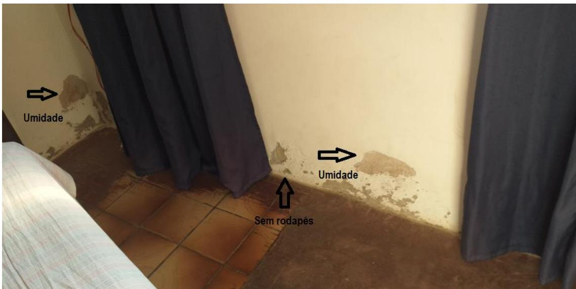
Nas fotos acima no 2º dormitório, pode se ver umidades na parte debaixo das paredes, falta de piso cerâmico no chão e falta de rodapés.
