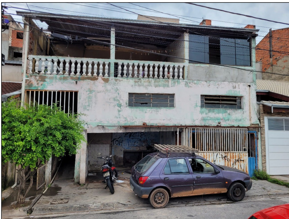
Figura 1 - Vista da fachada da edificação
