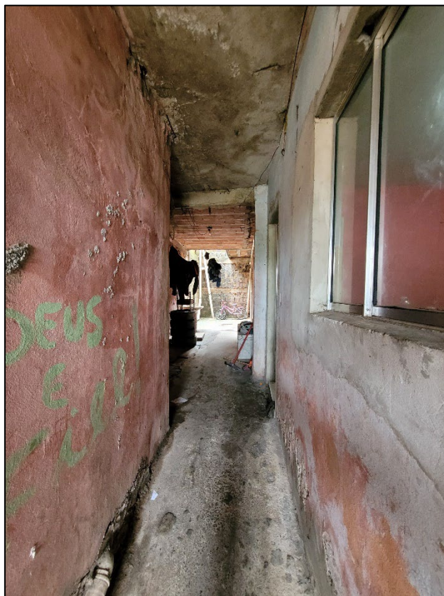
Figura 6 - Acesso à casa 1
