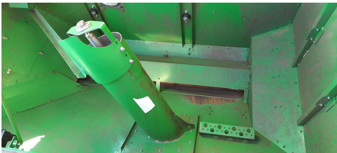
Tanque graneleiro íntegro sem pontos de ferrugem ou danos aparentes.
