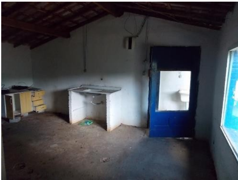
Vistas internas das construções.
