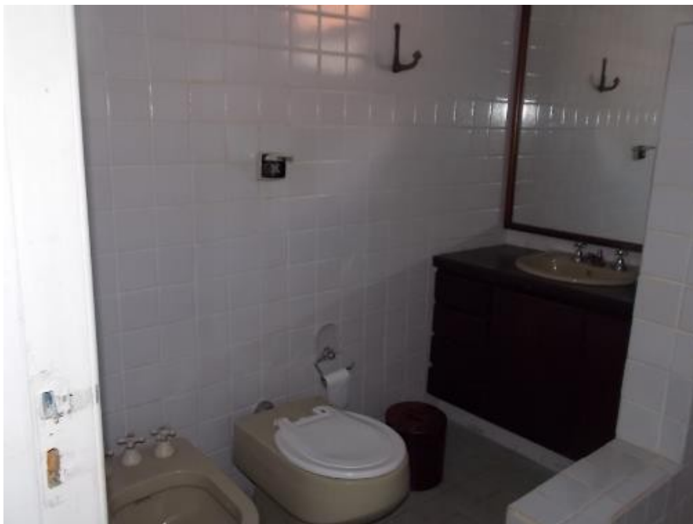
Vistas dos banheiros.
