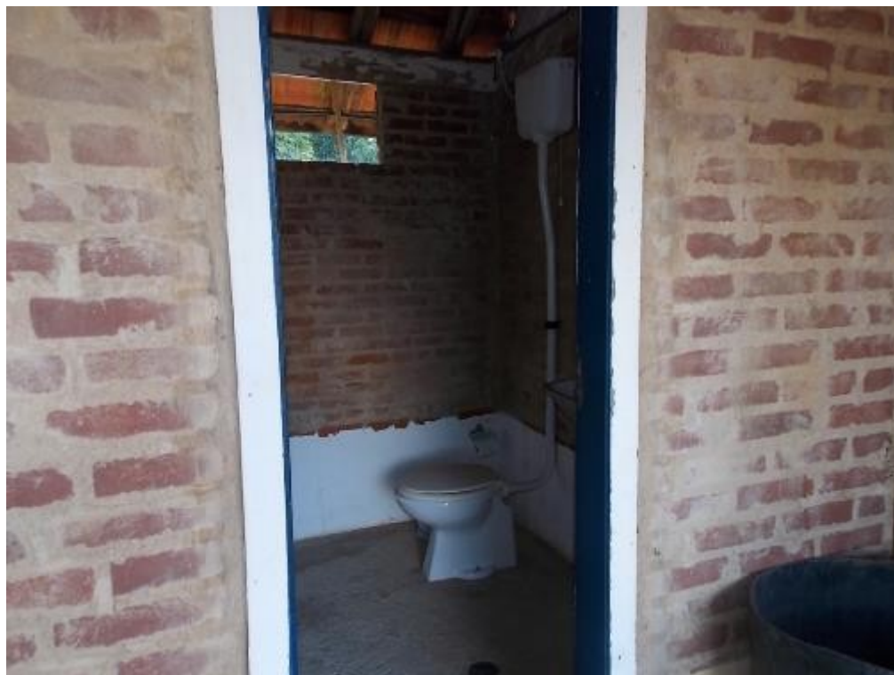
Vistas dos banheiros.
