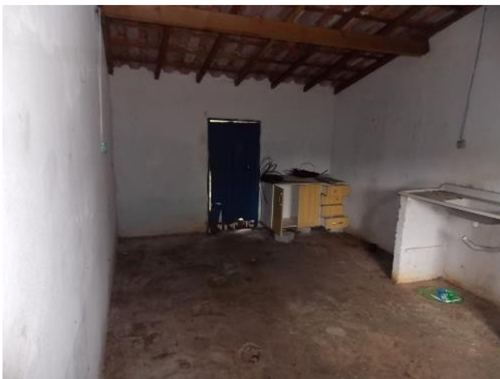
Vistas internas das construções.
