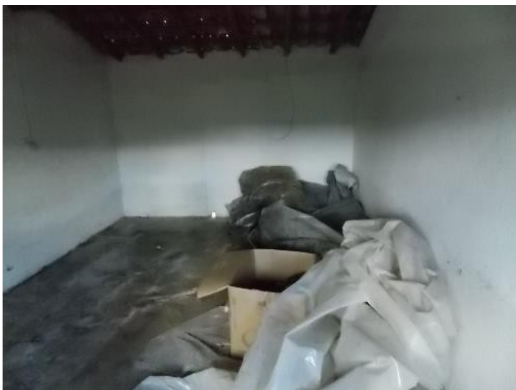
Vistas internas das construções.
