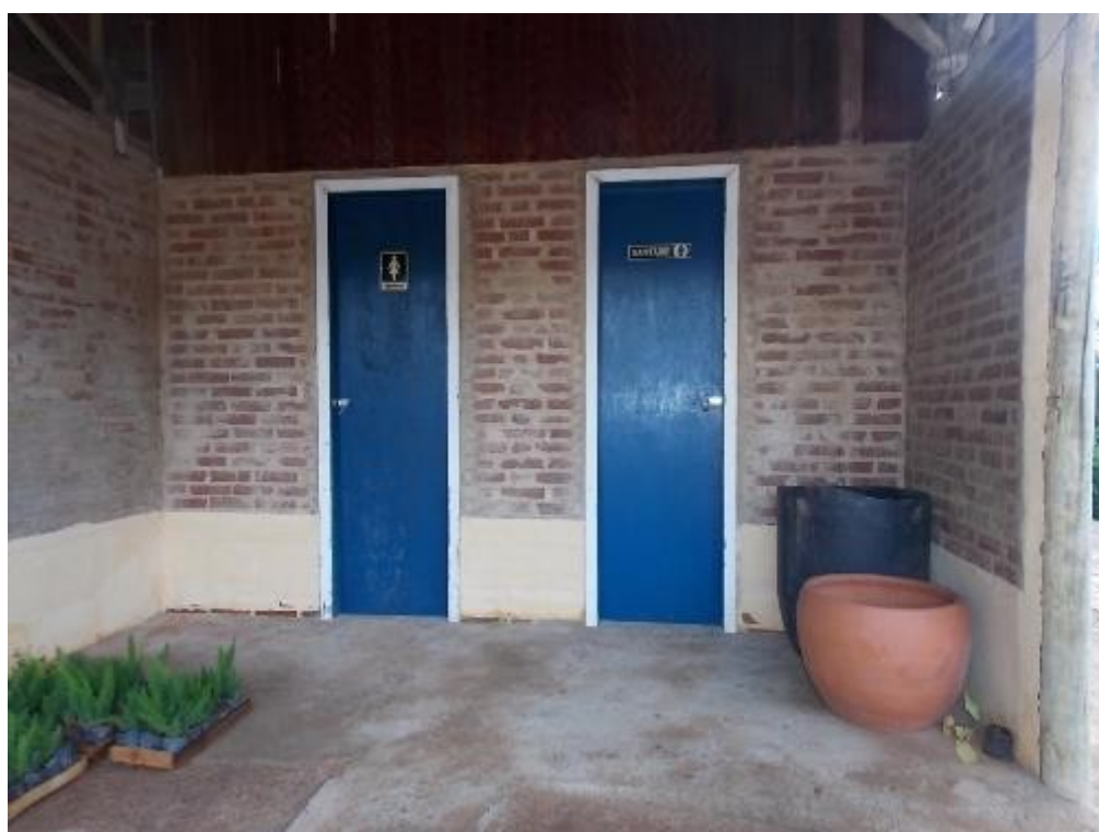
Vistas dos banheiros.
