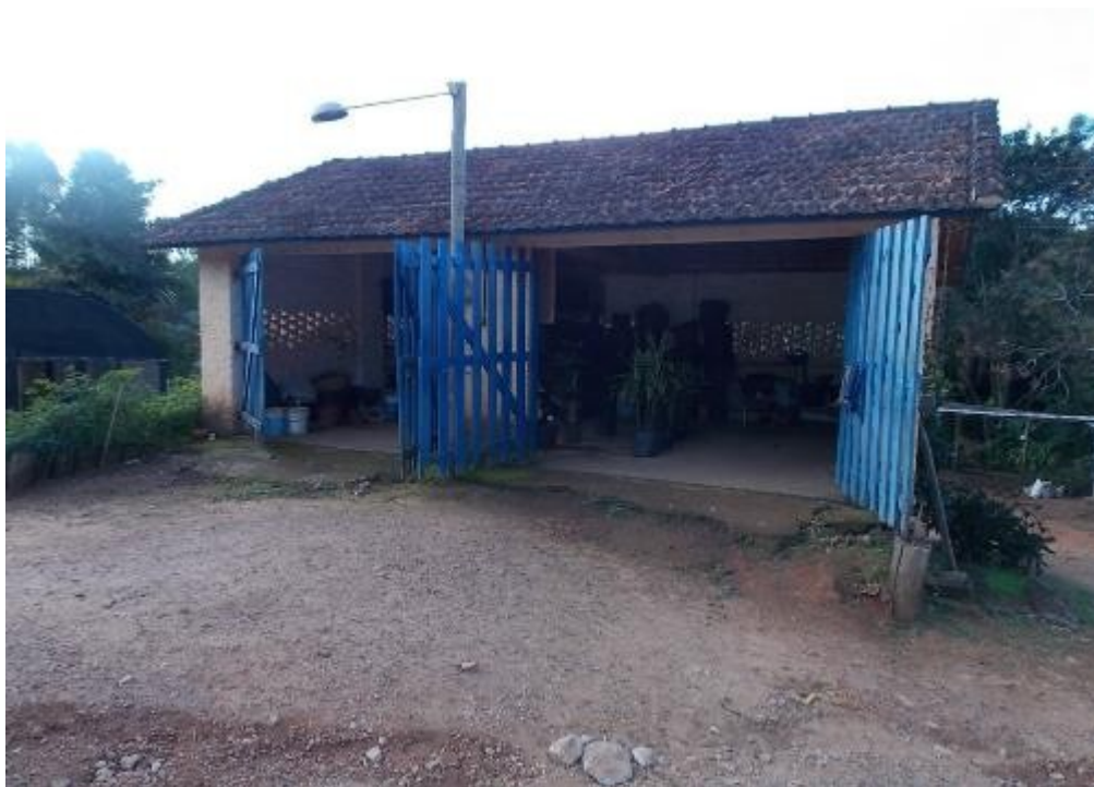
Vistas da construção.
