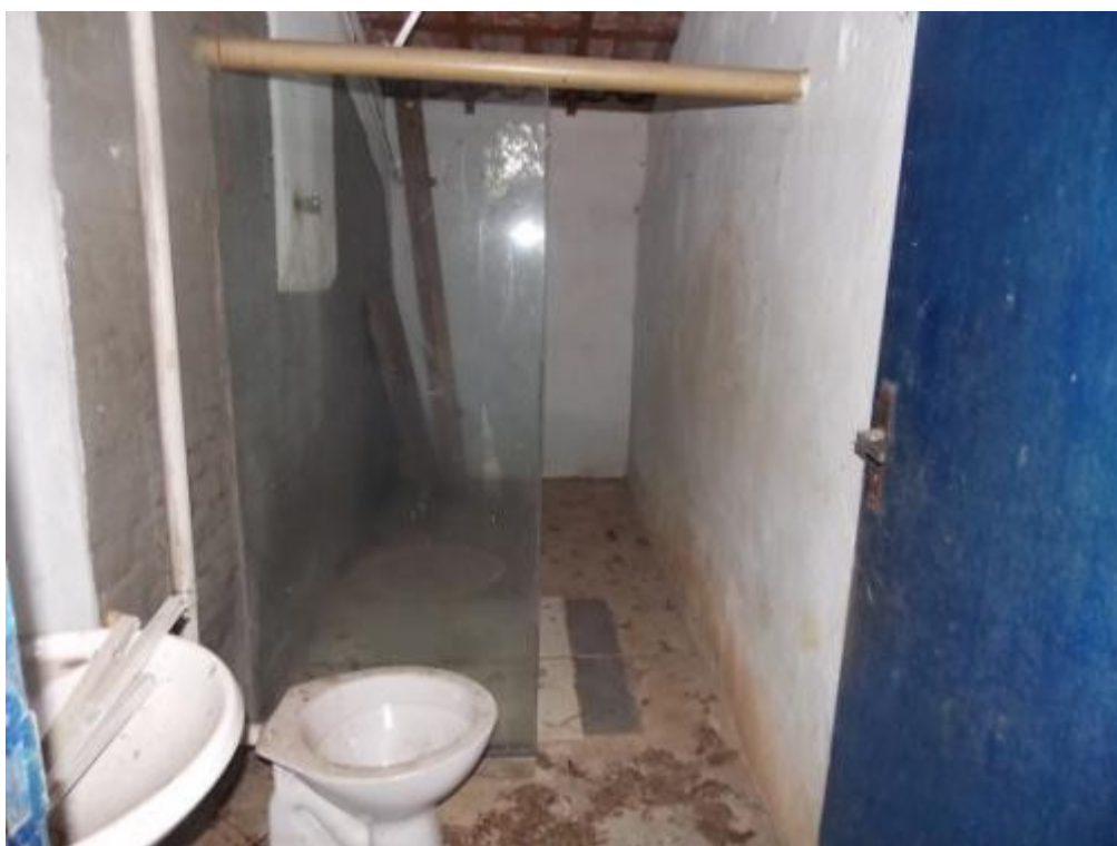
Vistas internas das construções.
