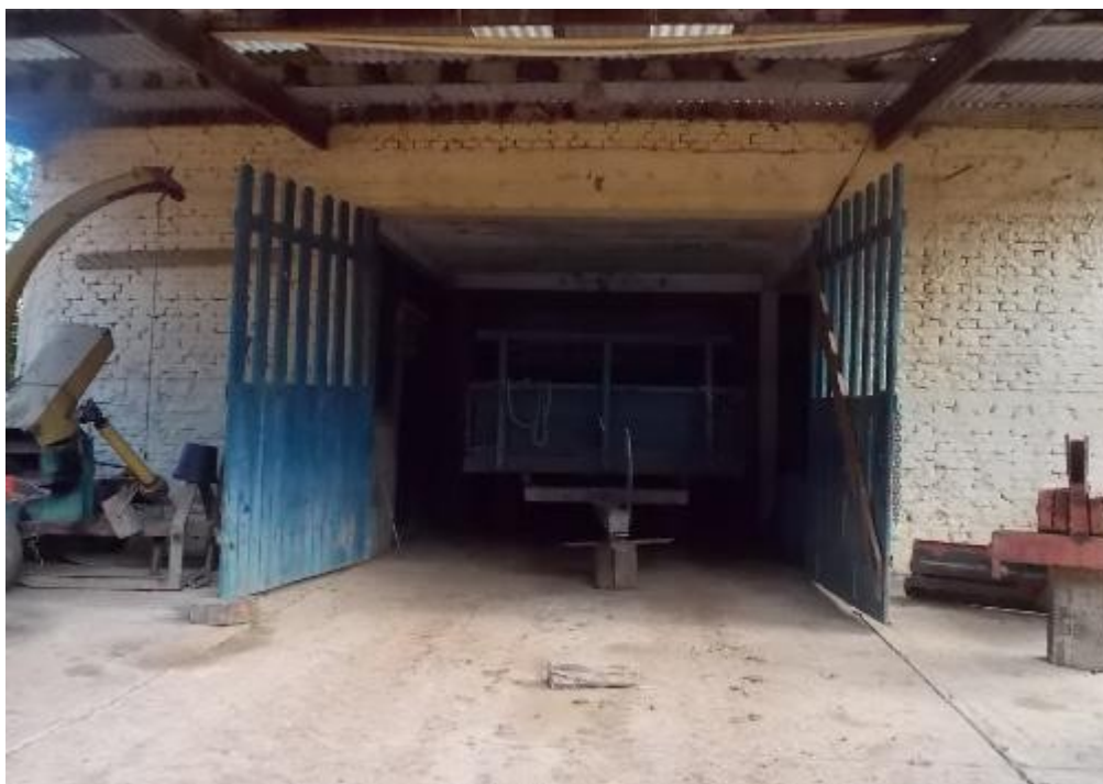
Vistas da construção.
