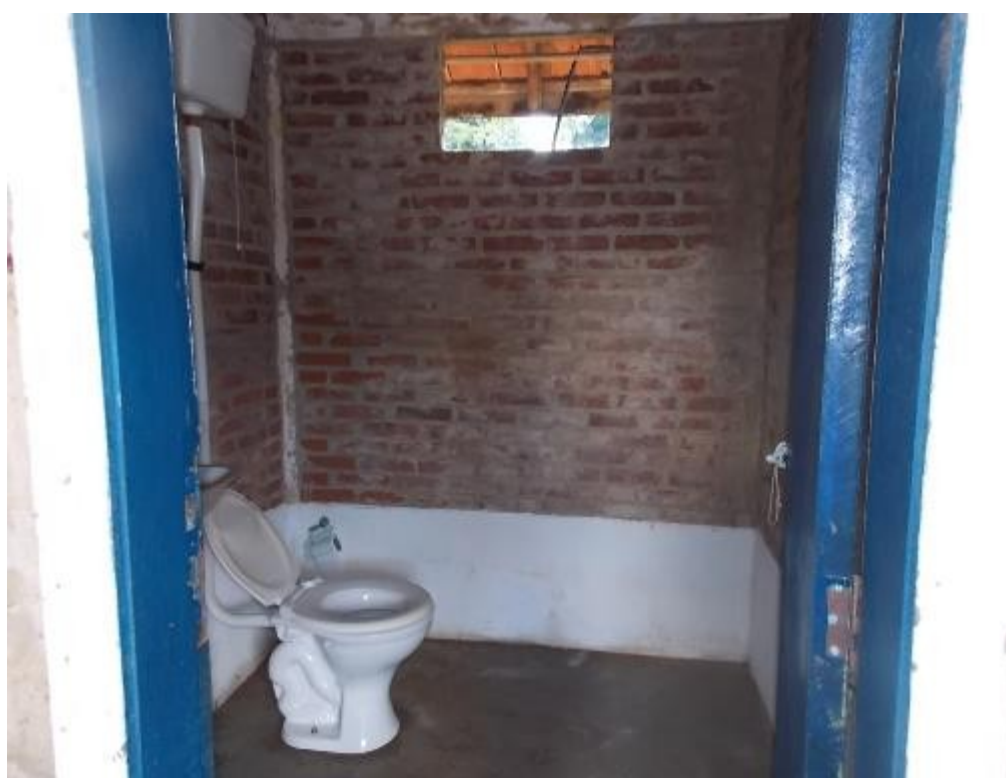
Vistas dos banheiros.
