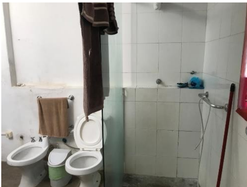
Vistas do banheiro 02.
