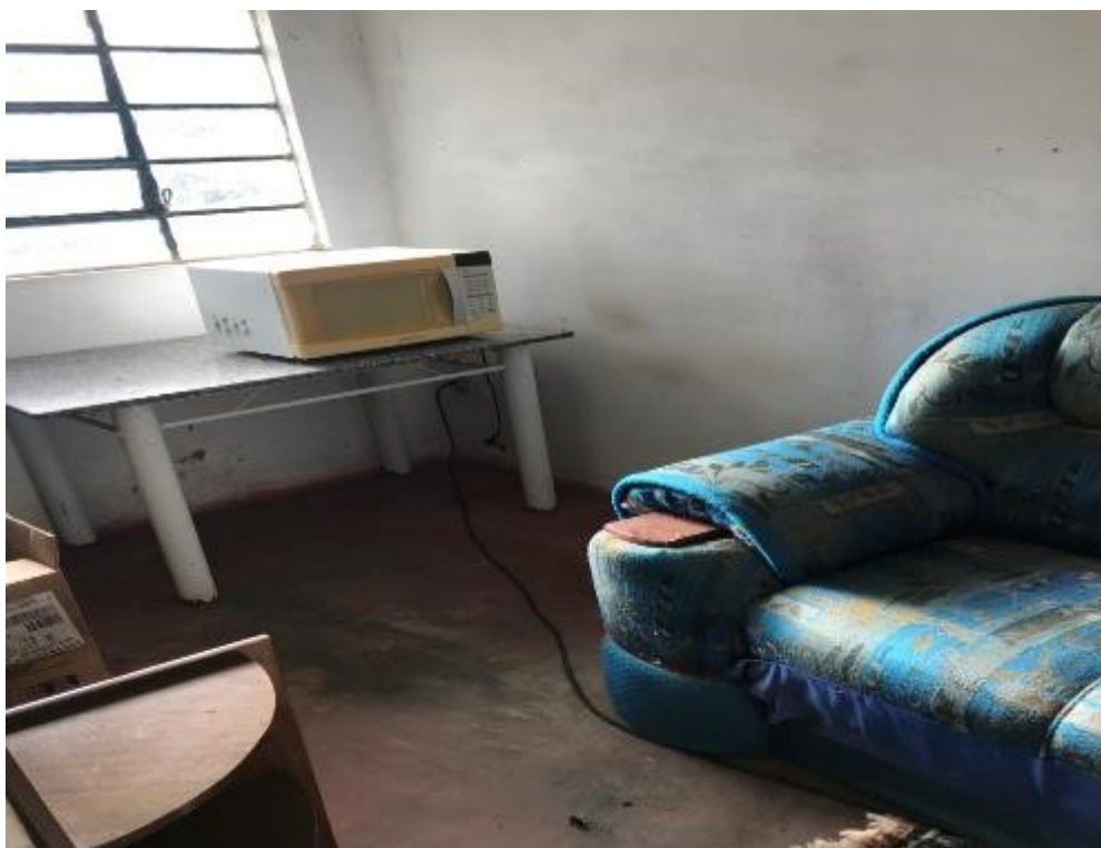
Vistas da sala.
