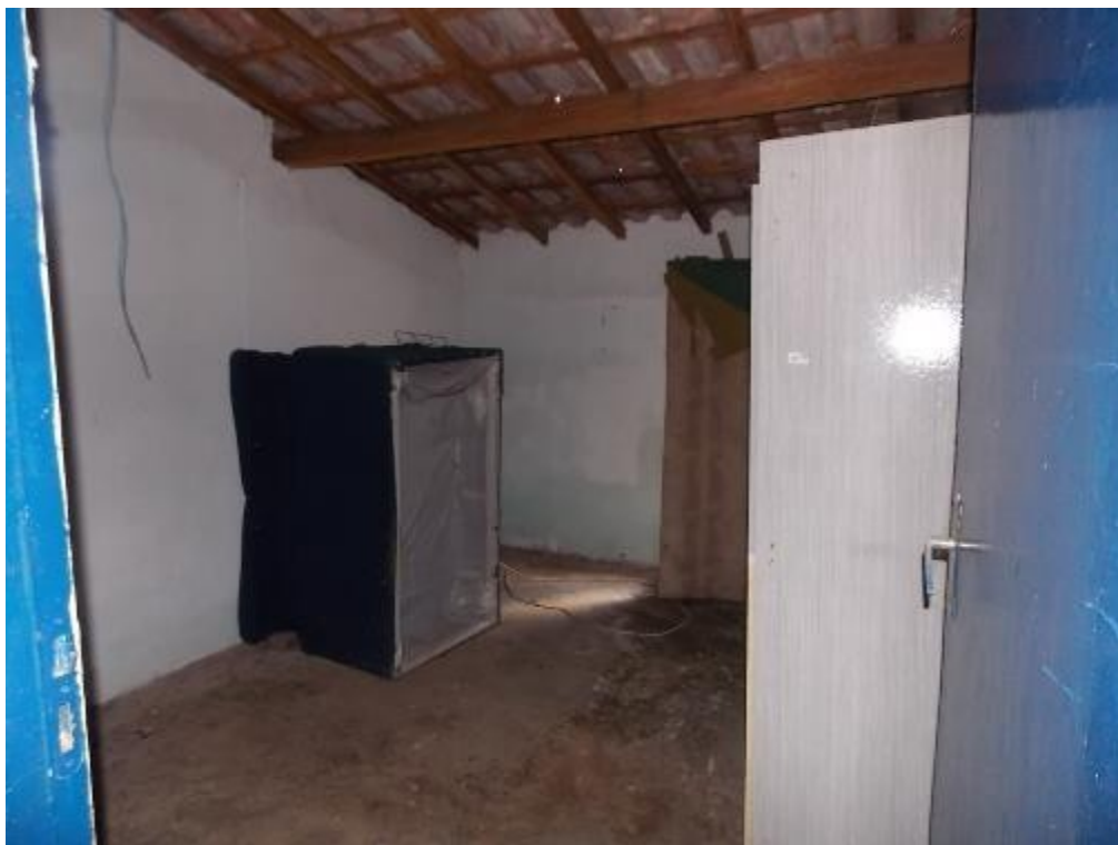
Vistas internas das construções.
