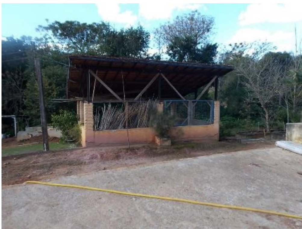
Vistas da construção.
