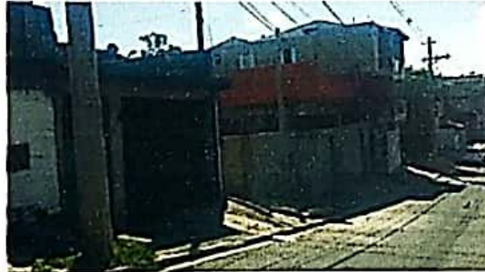
Foto 3 – Vista lateral direita com logradouro.
