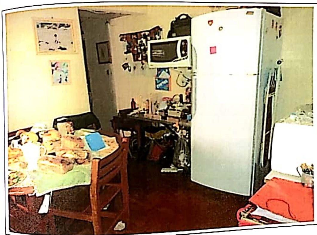
Foto 06: Vista da sala. Suas principais características construtivas são: piso em tacos de madeira, paredes revestidas em massa corrida, pintadas em látex, forro em laje e esquadrias de ferro.
