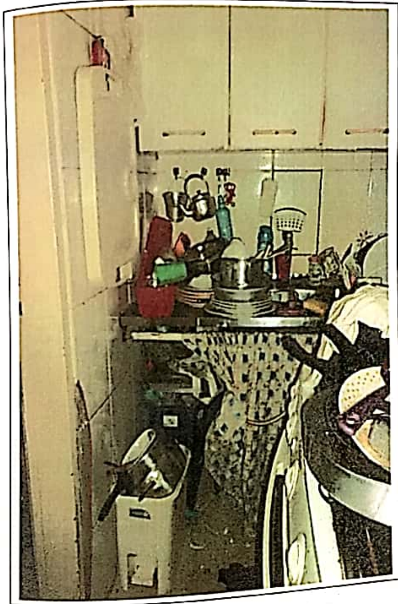
Foto 08: Vista da cozinha. Suas principais características construtivas são: piso cerâmico, paredes azulejadas até o teto, forro em laje e esquadrias de ferro.
