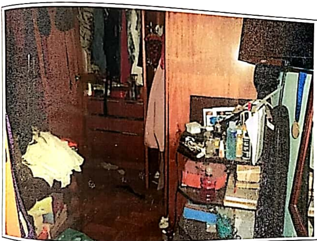
Foto 10: Vista do segundo dormitório. Suas principais características construtivas são: piso em tacos de madeira, paredes revestidas em massa corrida, pintadas em látex, forro em laje e esquadrias de ferro.
