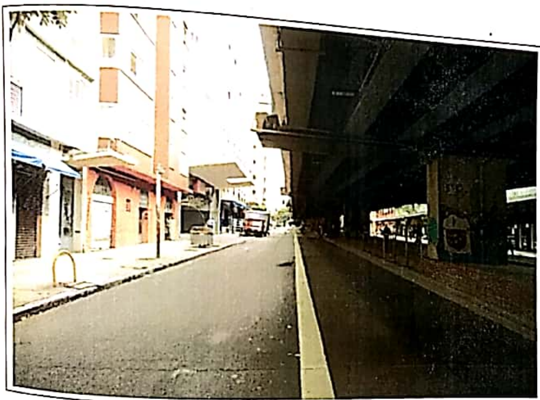
Foto 01: Vista da Avenida São João. O observador encontra-se defronte ao Edifício Araraunas sob o nº 1.833, olhando em direção a Alameda Gleite.
